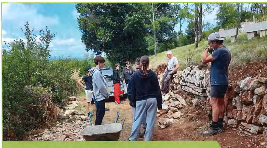
Chantier jeunes sur le Sentier Mémoire de Pierre
